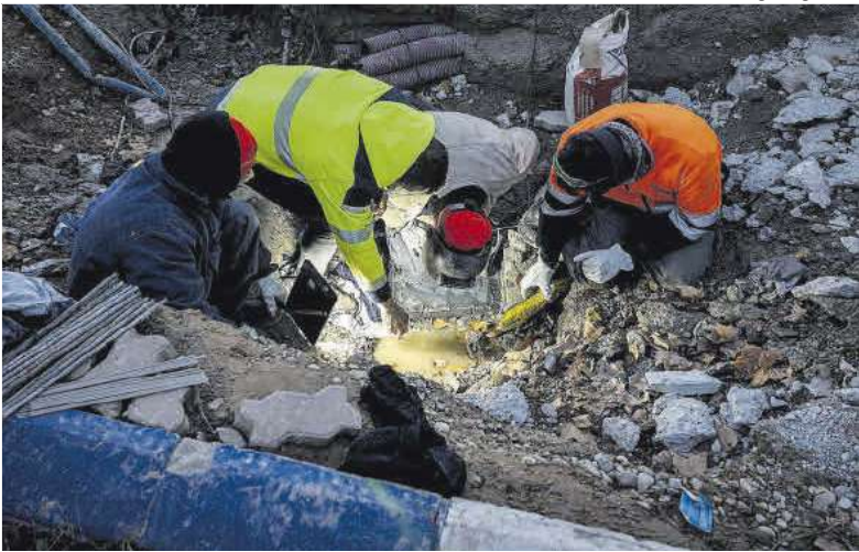
Operarios del Ayuntamiento de Zaragoza, trabajando ayer en la reparación de la tubería dañada en la N-232.
