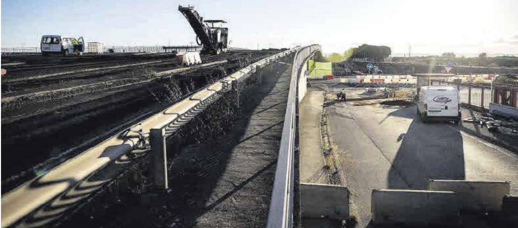
La demolición del puente carretero que conecta a Utebo con el centro comercial de Alcampo comenzará esta semana.
